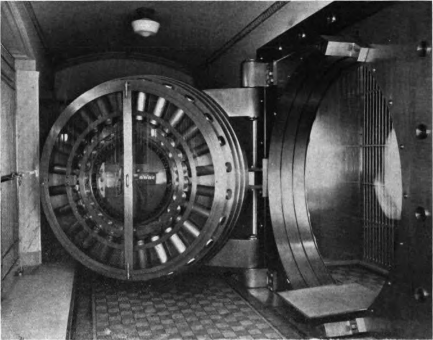
Twenty-two ton vault door
